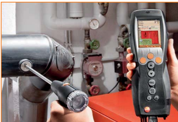
Рис. 13: Определение уровня потерь тепла с дымовыми газами
