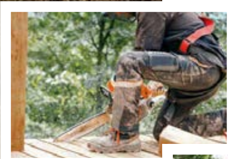
Когда все балки уложены, край выравнивается пилой
