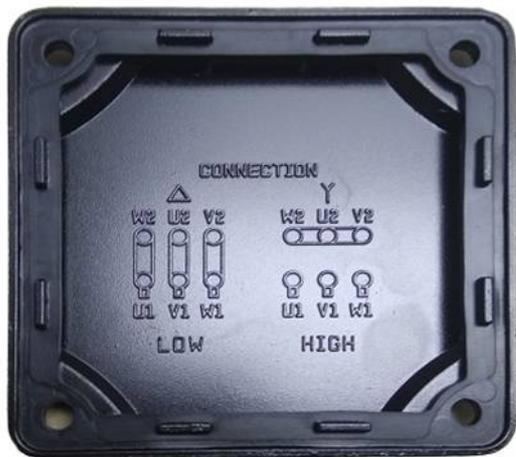
Подключение по схеме «треугольник» (Δ).
