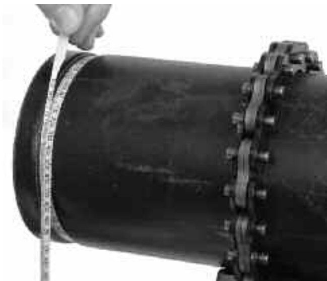
Figur 16 – Måling af rillediameteren med et diametermålebånd
