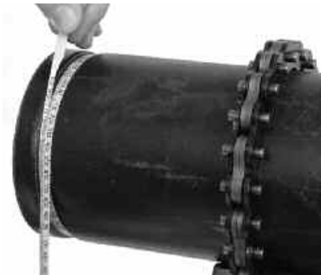
slika 16 – Mjerenje dijametara spojnice pomoću vrpce za mjerenje dijametara
