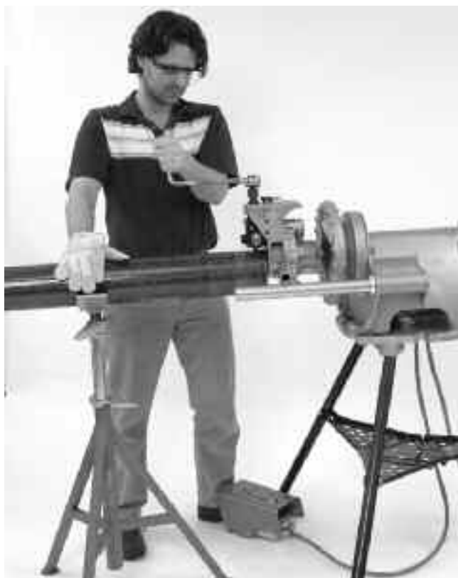
Figur 13 – Påførsel af belastning på røret under rilning for at opretholde sporing
