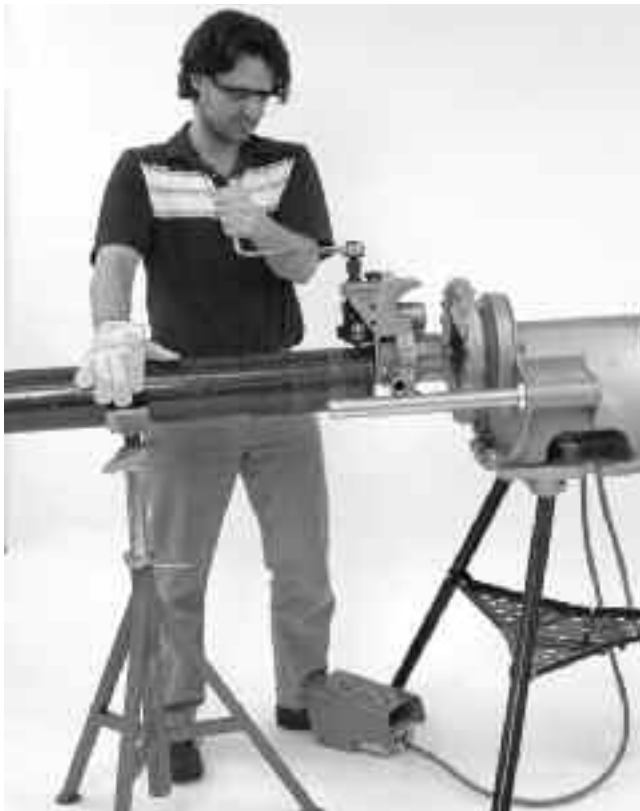
Figuur 13 – Kracht uitoefenen op de pijp tijdens het groeven om ervoor te zorgen dat de pijp beter volgt
