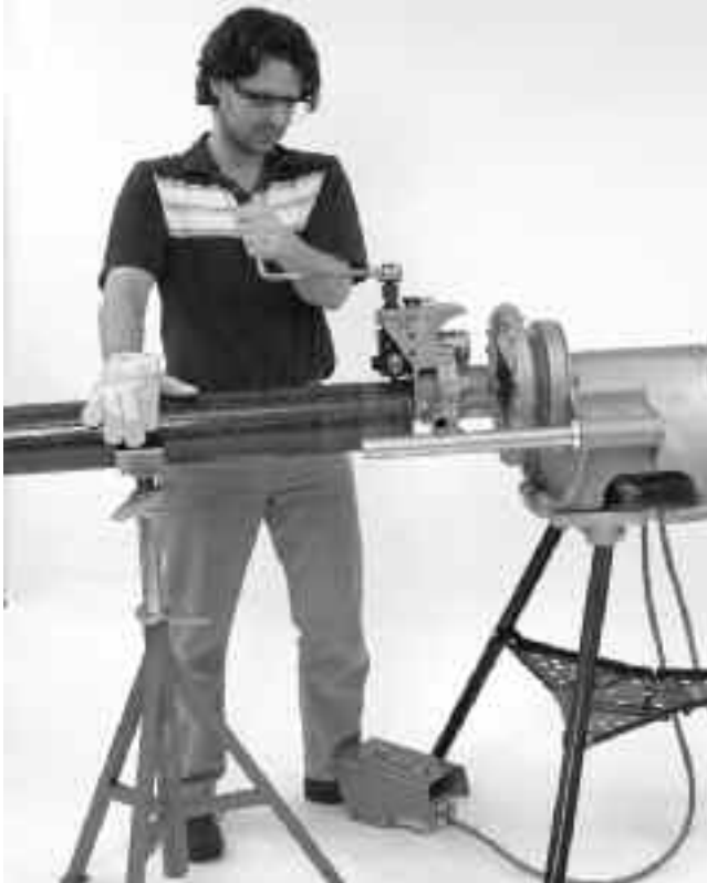
Abbildung 13: Ausüben von Kraft auf das Rohr während des Nutens, um die Spurführung beizubehalten
