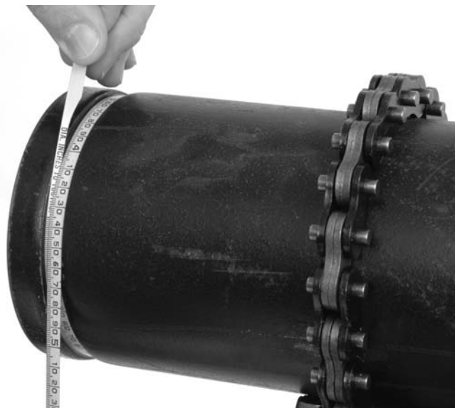
Εικόνα 11 – Έλεγχος διαμέτρου εγκοπής με ταινία διαμέτρου
