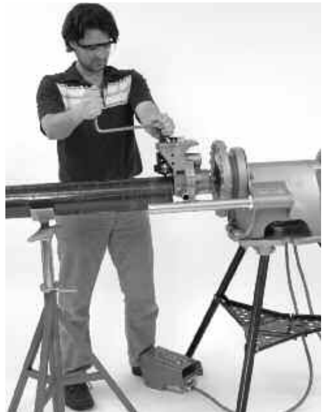
Figur 12. Arbetsställning vid spårfräsning
