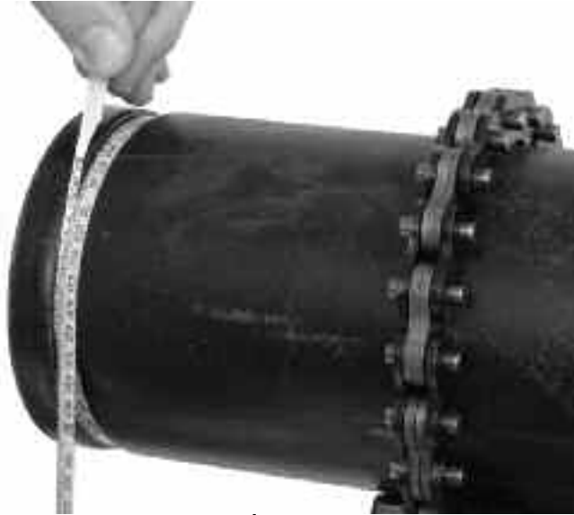
Şekil 11 – Bir Şerit Metre ile Yiv Çapının Kontrol Edilmesi
