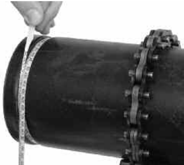
Рисунок 11 – Проверка диаметра желобка с помощью измерительной ленты
