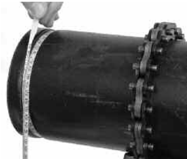
Slika 16 – Merenje prečnika žleba trakom za merenje prečnika
