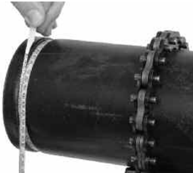
Figura 11 – Verificarea diametrului canelurii cu o ruletă pentru diametru
