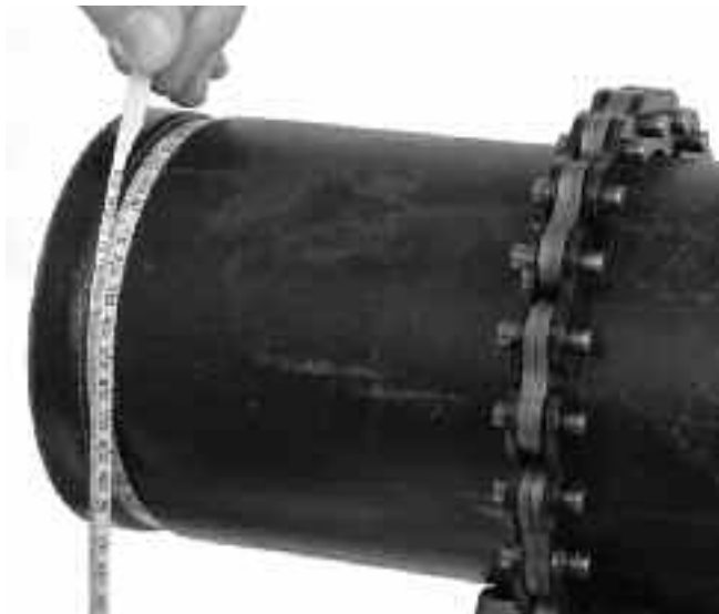
Obrázok 16 – Meranie priemeru drážky pomocou hrúbkového pásma
