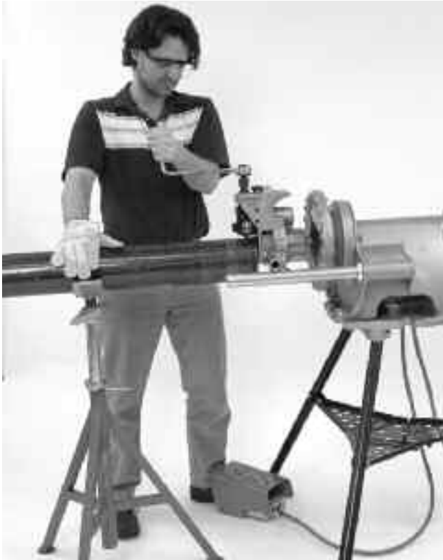
Figura 13 – Aplicando pressão no tubo durante o entalhamento para nater o trilha
