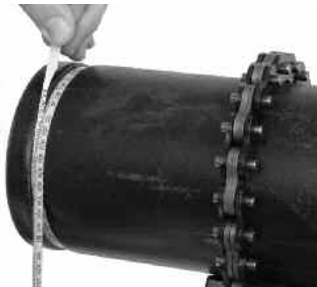
Slika 11 – Preverjanje premera utora s tračnim metrom
