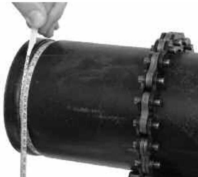
11. ábra: Horonyátmérő mérése átmérőmérő szalaggal
