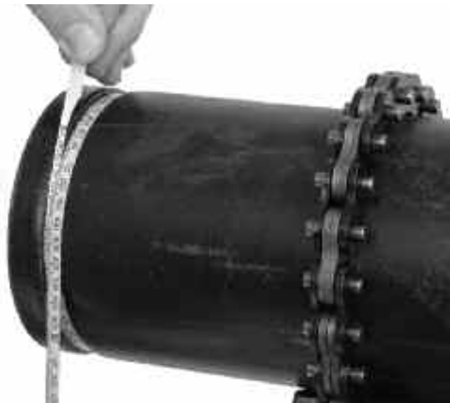
Figur 11. Mätning av spårdiametern med ett diametermåttband
