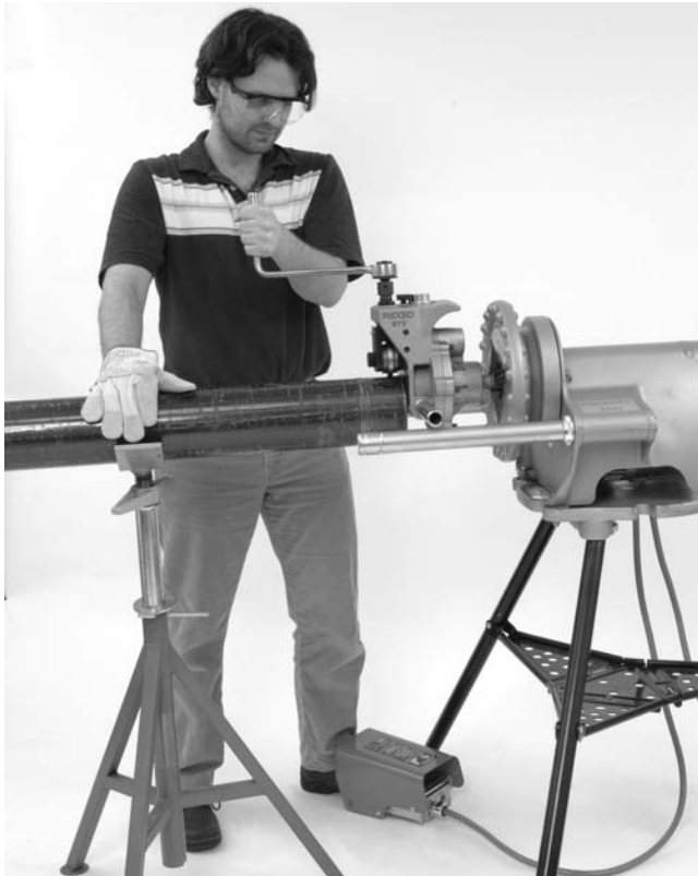
Εικόνα 13 – Εφαρμογή δύναμης στο σωλήνα κατά τη δημιουργία εγκοπής για τη διατήρηση της πρόσφυσης
