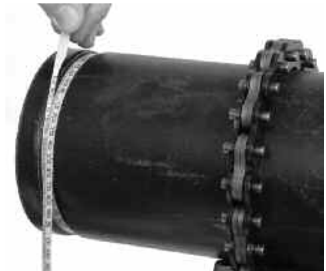
Figura 16 – Măsurarea diametrului canelurii cu o ruletă pentru diametru
