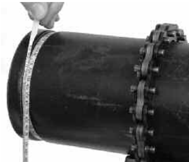
Figura 16 – Misurazione del diametro della scanalatura con un nastro per diametri
