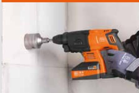
Высверливание отверстий под розетки (диаметр 68 мм) в кирпиче.
