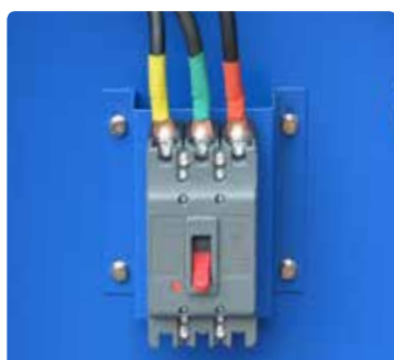
Автомат защиты генератора
