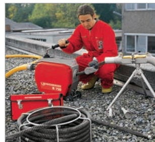
Удобный монтаж зажимных цанг для спиралей \varnothing 8, 10, 16 мм
