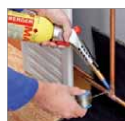
Пайка при монтаже системы подачи газа
