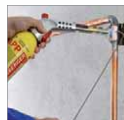
Пайка мягким припоем при монтаже системы отопления
