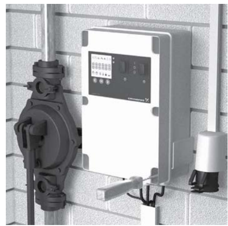
Նկար 7 LC 221 կառավարման պահարանի տեղադրման օրինակ
