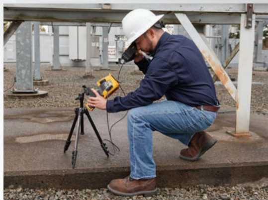
Обследование оборудования с безопасного расстояния при помощи штатива с держателем и видеоскопеля
