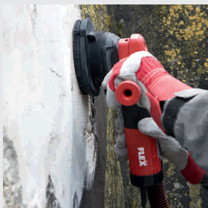
Новая машина RETECFLEX играючи справляется даже с сильно обветренным старым бетоном.
