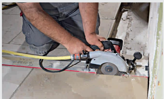
Бесступенчатое управление глубиной резания 0-60 мм (с направляющей шиной 0-54 мм) в особенности подходит для изготовления деформационных швов и чистовой отделки ребер при изготовлении полов.
