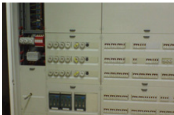
Нагрузка в блоках предохранителей распределяется неравномерно
