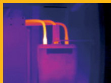
Ненадежные соединения и внутренние повреждения
