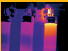
Внутренние повреждения предохранителей
