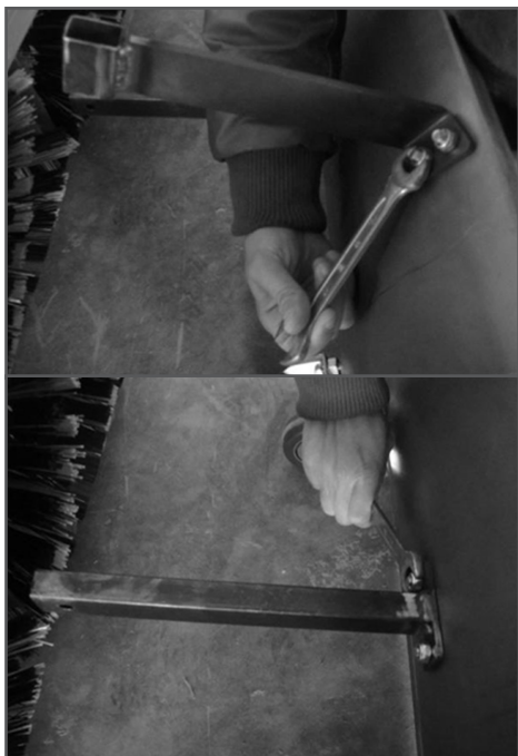
Рис. 2 Установка кронштейнов крепления отвала
